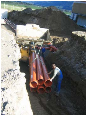
Anlieferung der Rohre
