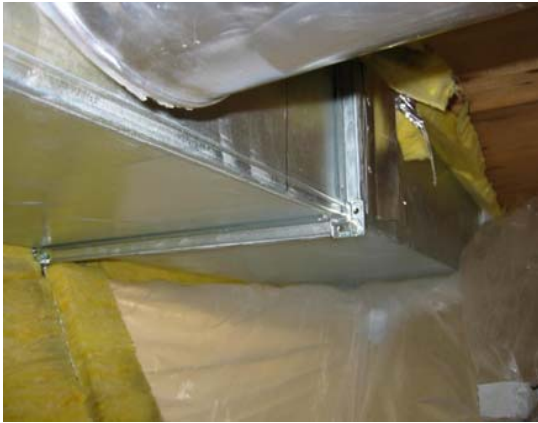
Befestigung des Kanals direkt an der Decke
