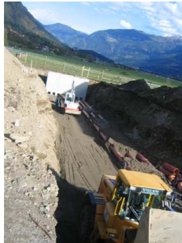
Erdkollektor verlegt + befestigt
